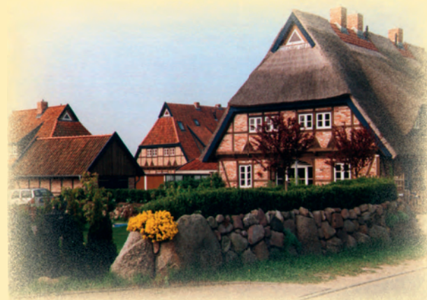
Fachwerksiedlung in Rethwisch
