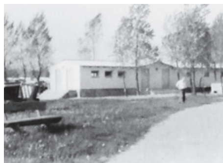
Toiletten- und Waschhaus 1972
