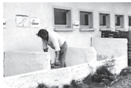
An jeder Toilette wurden solche Lagerstellen für Altstoffe bereits vor 7 Jahren gebaut.
