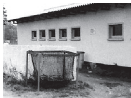
Altstoffsammelstelle auf der Toilettenrückseite
