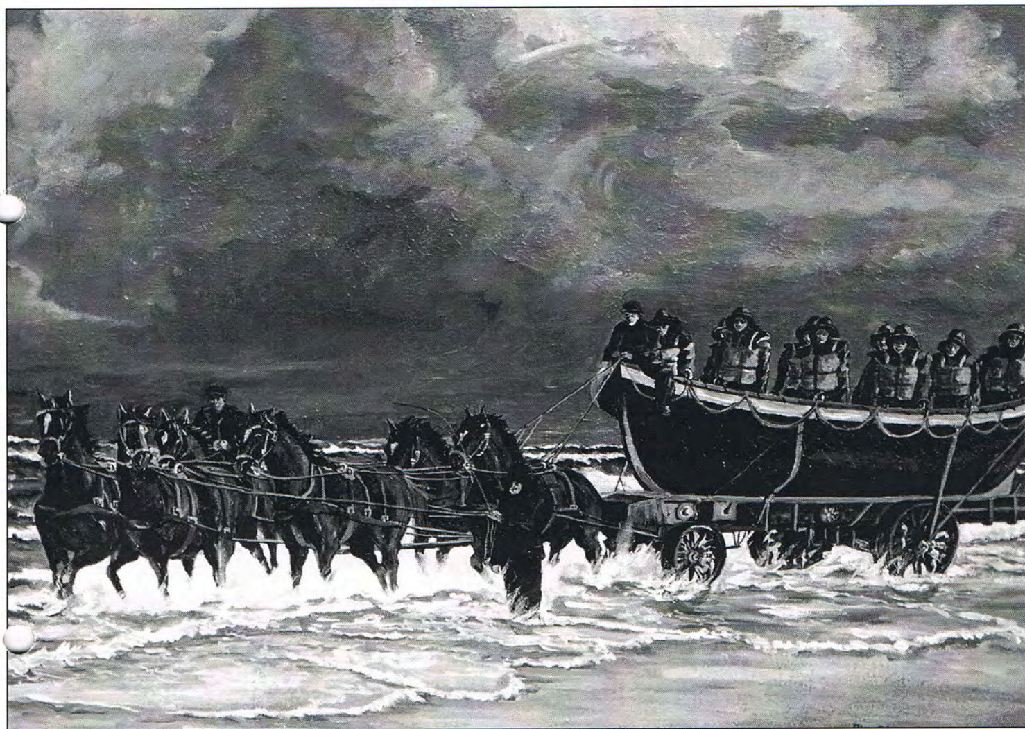
Das Rettungsboot wird von einem Sechserpferdezug in das Rettungshaus eingebracht (um 1910)
