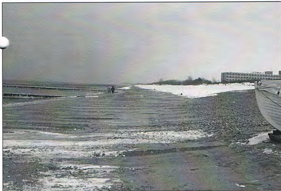
Das Bild zeigt dieses Gebiet nach Fertigstellung der Geröllwallverstärkung Ende Januar 2004. Deutlich wird trotz der "Sichtbehinderungen" durch den Schnee, dass auch nach der nunmehr erfolgten Geröllwallaufschüttung selbst zur im Jahreslauf eher "sandarmen" Winterzeit noch ein Sandstrand übrig geblieben ist.
